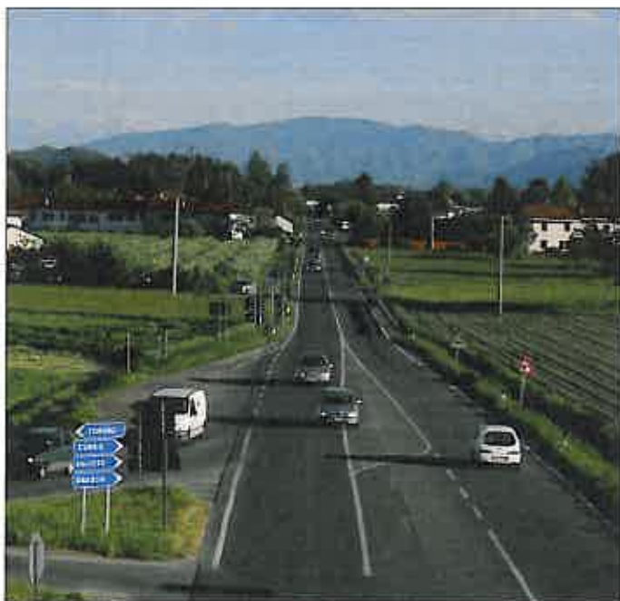
Il tratto di Strada provinciale che collega Osasco a Ponte chisone, un nodo vitale per la comunicazione locale.
